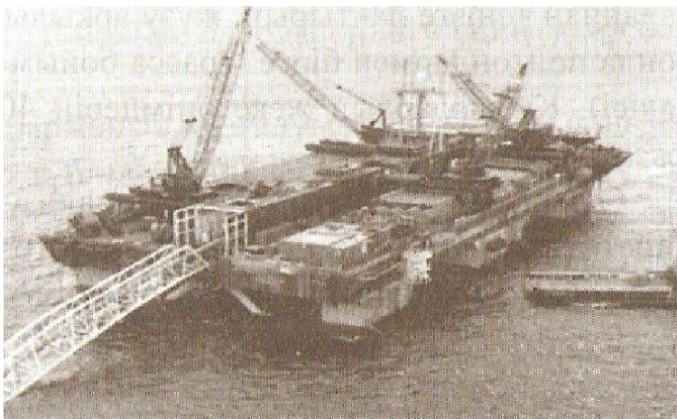
5.1-сурет. Суастында құбыржелілерді төсеуге арналған баржа
