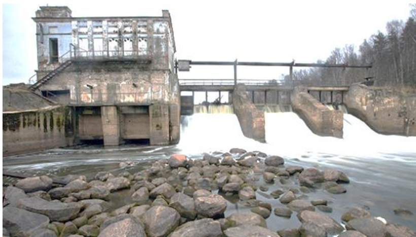
Рис. 6.2. Общий вид водозаборного сооружения со шлюзом-регулятором
