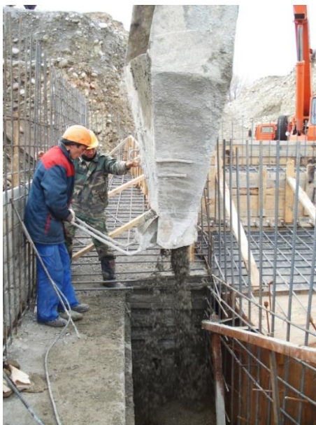
Рис. 10.3. Бетонирование подготовки под блоки I яруса
