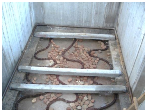
Рис. 10.5. Обогрев бетона при строительстве в зимних условиях
