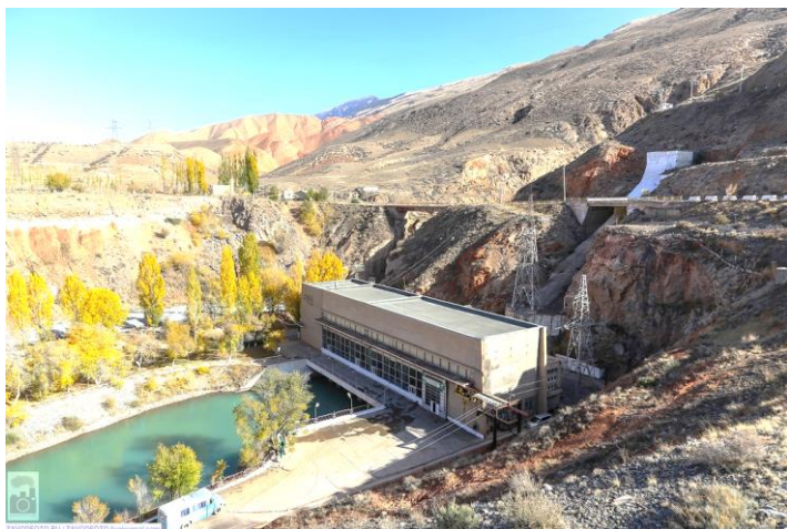
Рис. 1.5. Вид приплотинной деривационной ГЭС
