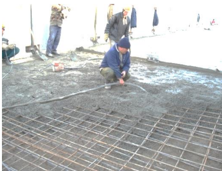
Рис. 10.2. Заливка и уплотнение бетона на дно деривационного канала
