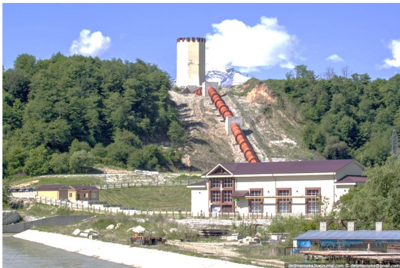
Рис. 1.7. Вид малой ГЭС деривационного типа
