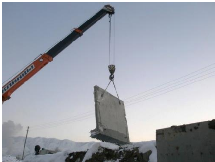
Рис. 10.1. Установка автокраном Г-образного блока деривационного канала
