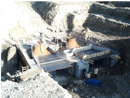
Рис. 10.4. Строительство нижней части малой ГЭС и установка отсасывающей трубы
