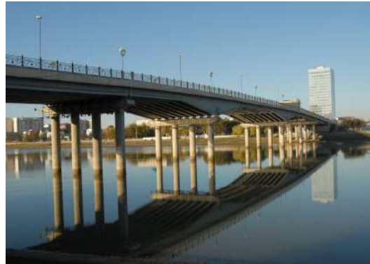
Рисунок 10 – Центральный мост в Атырау
