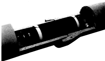
Рис. 4.14. Фрагмент ремонтного участка трубопровода с установленной в нем ремонтной гильзой Grouting Sleeve
