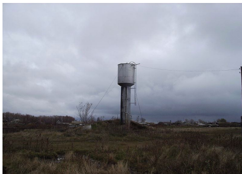
Рис. 4.16. Водонапорная башня Рожновского
