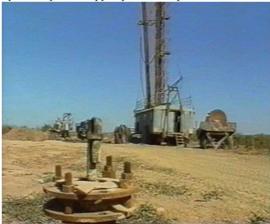
Рисунок 4.2 – Буровая установка ПБУ-ЗИФ1200МЗ (на переднем плане устья экспериментальной скважины)
