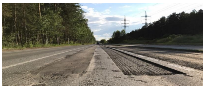
2 сурет - Күштік тұйықталу бойынша басқару кезінде жол жабындыларының шығырымдарын фрезерлеу нәтижесі
