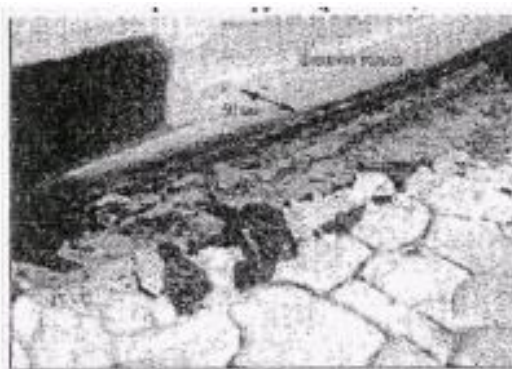
6.13-сурет. Бетасты коррозияның көрінуі
