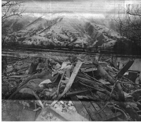
Рис. 7. Последствия схода оползня в пос. Талды-Булак Алматинской области (2004 г.)
