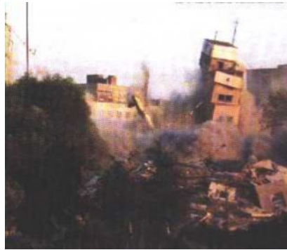
Рис. 6. Разрушение зданий землетрясением
